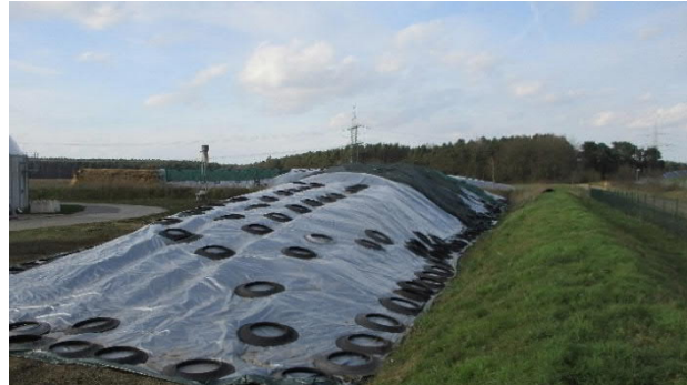
Abbildung 9: Blick über den östlichen Erweiterungsbereich nach Norden (gepl. Standort für Notfackel)
