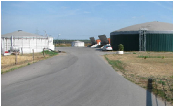
Abbildung 4: Zufahrt zum Betriebshof
