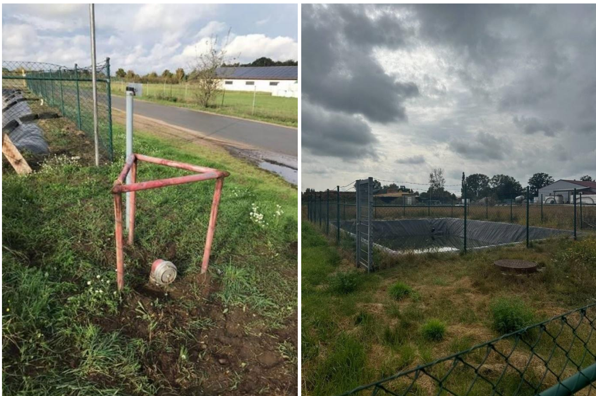
Abbildung 7: Löschwasserbrunnen (links), Löschwasserteich (rechts) (EnviTec Biogas, 03.2025)
