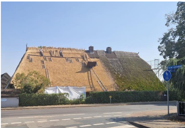
Abb. 10: Sanierung des Reetdaches
