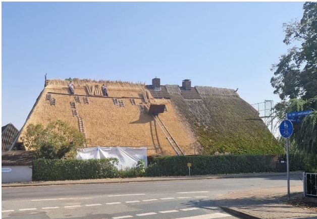
Abb. 10: Sanierung des Reetdaches
