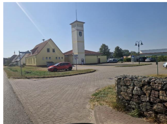
Abb. 22: Feuerwehrgebäude in Banzkow
