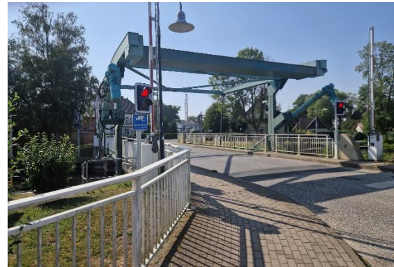
Abb. 16: Klappbrücke über die Störwasserstraße
