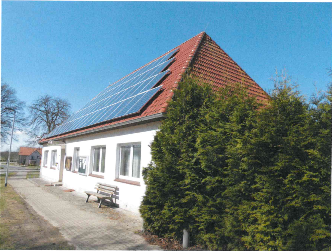
Bild 1: Vorder- und rechte Giebelansicht von der Straße aus
