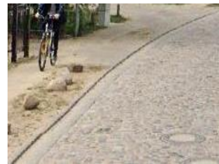
Gewölbtes Kopfsteinpflaster in Pinnow, Foto: Google Maps
