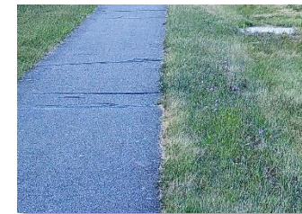
Asphalt-Radweg in Sukow
